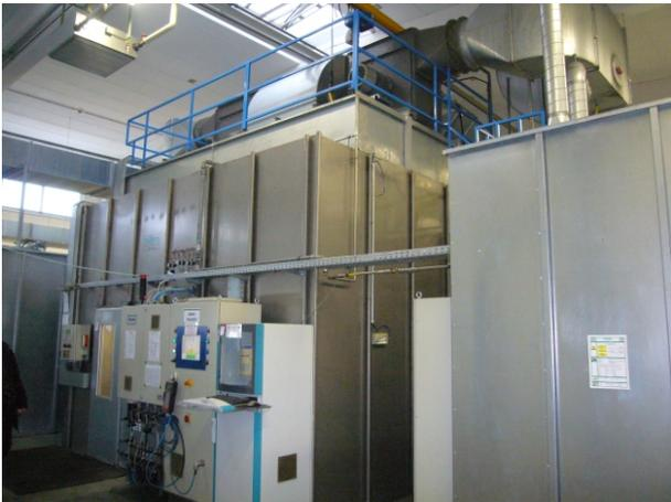
Abb. 1: Realisierte Trockenabscheidung von Nasslacken
