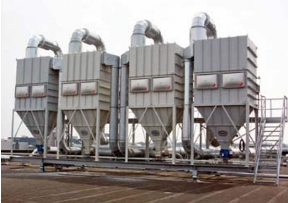
Die Entlastungsflächen an Filtergeräten öffnen sich bereits bei geringen Drücken und lassen die Explosion aus dem Behälter austreten
