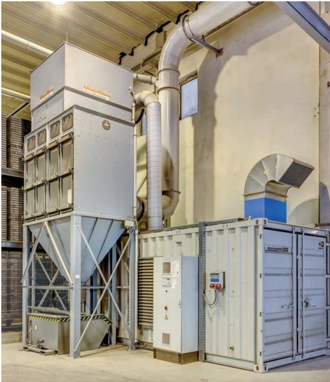
*Cabine d'aspiration avec recyclage d'air pur dans une chambre de compression*
