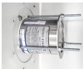
Aerosolgenerator bei der Brandbekämpfung
